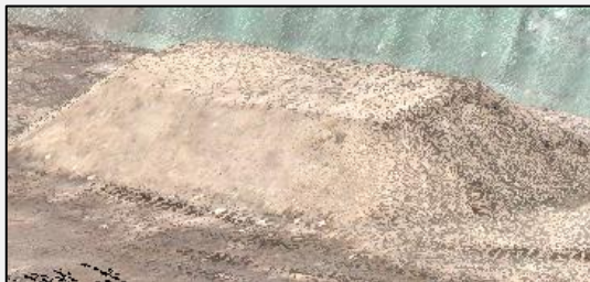
フラット化させたい盛土
